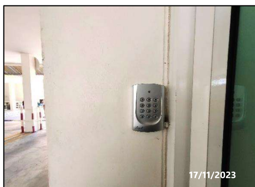
รูปที่ 2-44 ติดตั้งระบบ Key card สำหรับผ่านเข้า-ออก อาคาร
