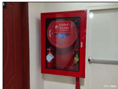
รูปที่ 2-27 ตู้เก็บสายฉีดน้ำดับเพลิงพร้อมอุปกรณ์
