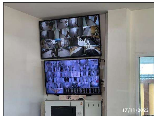
รูปที่ 2-43 ติดตั้งกล้องวงจรปิด CCTV บริเวณทางเข้า-ออกโครงการ และบริเวณจุดอับในหลายๆ ชั้น ภายในอาคาร
