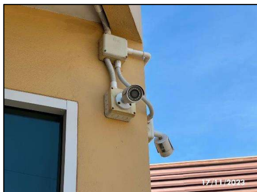
รูปที่ 2-43 ติดตั้งกล้องวงจรปิด CCTV บริเวณทางเข้า-ออกโครงการ และบริเวณจุดอับในหลายๆ ชั้น ภายในอาคาร
