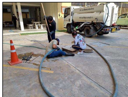
รูปที่ 2-11 ผู้รับเหมามาสูดกากตะกอนออกจากบ่อ เมื่อบ่อเกรอะเต็ม
