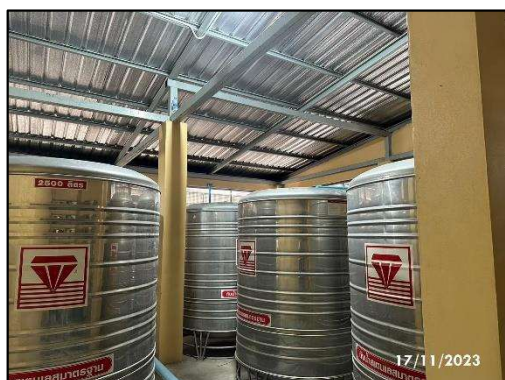
รูปที่ 2-12 จัดให้มีถังสำรองน้ำใช้บนดิน และถังสำรองน้ำใช้ชั้นหลังคา
